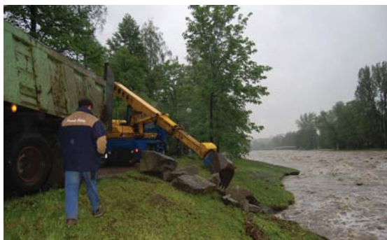
VYMÍLANÉ BŘEHY: Těžká technika a lomový kámen se úspěšně postavili zdivočelé řece. Foto: Petr Pavelka
