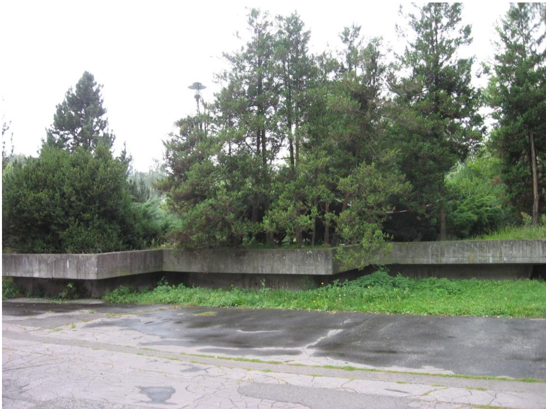
2. Výškový rozdíl mezi středovou zpevněnou plochou a úrovní chodníku podél ulice Pionýrů byl vyřešen betonovými zídkami, betonovými žlaby s výsadbou dřevin a schodištěm.
