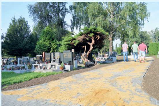
OPRAVENÉ CHODNÍKY: Narušené povrchy nahradila zámková dlažba.
