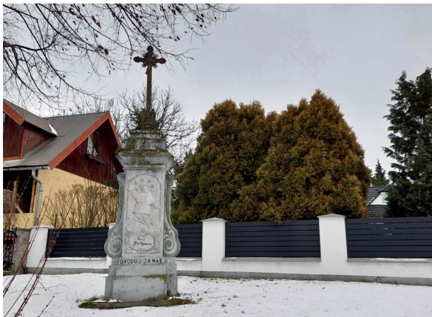
POŠKOZENÁ BOŽÍ MUKA VE VRŠAVCI POTŘEBUJÍ OPRAVIT. FOTO: RENÉ STEJSKAL
