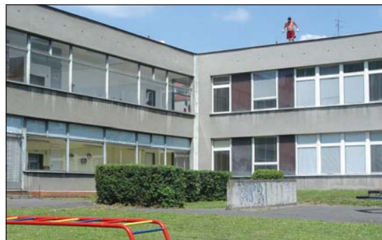
MŠ GOGOLOVA: Oprava střechy.
