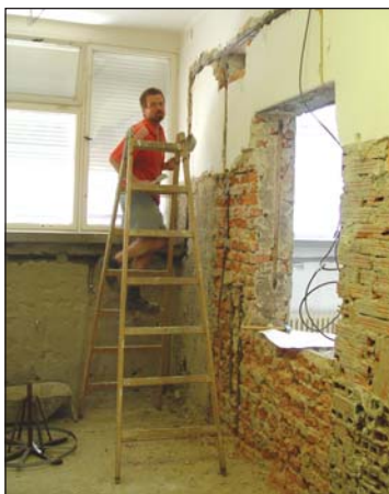
2. ZŠ: Generální oprava elektroinstalace.
